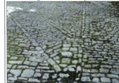
Pavage existant et son système de noues
