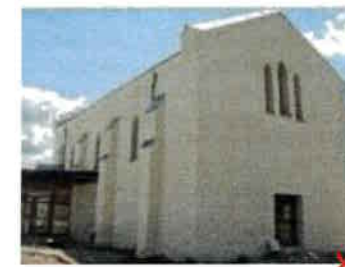
1.9.2 Vêlage : Bardage incorporant un isolant.
