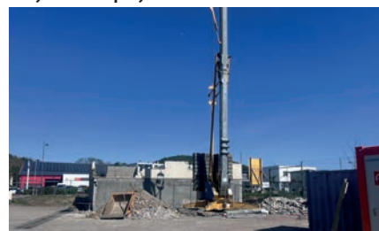
Chantier de la maison du stade
