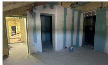
Vestiaire en cours de travaux
